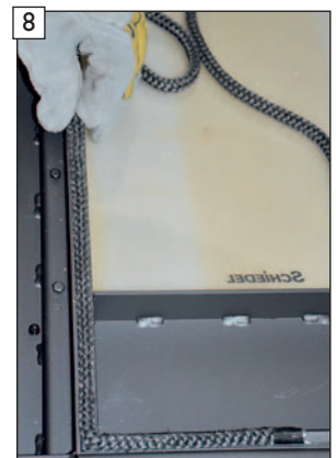
8 Dichtschnur mit beiden Fingern ca. 1/3 in die Klemmschiene einstecken.
