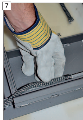
7 Vorgeklebten Dichtschnurstoß mittig an der unteren Klemmschiene anordnen.
