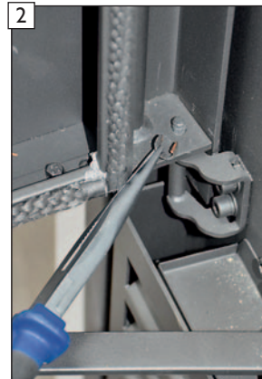
2 ... unten am Scharnier der Brennkammertür entfernen.
