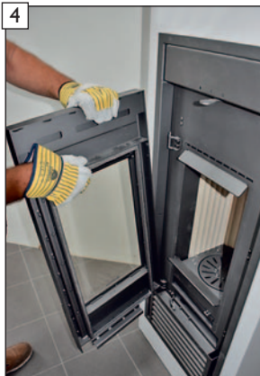
4 Brennkammertür aushängen. ACHTUNG! Beschädigungen vermeiden!
